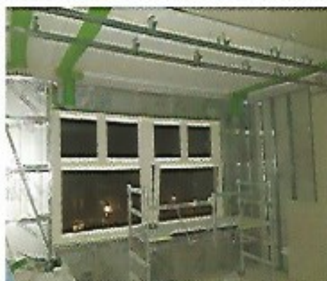
Renovatie binnen, dit is de harde realiteit
