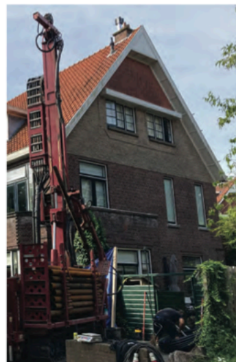
Gevel met boormachine
